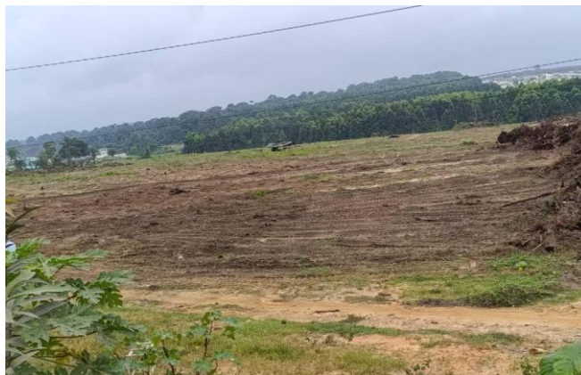
Photo 2 : Aménagement d'un site agricole pour la construction de logement à N'dotré
