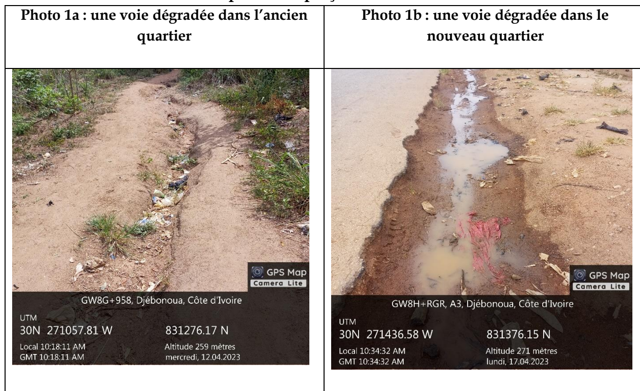
Planche de photo 1 : aperçu de l'état de la voirie
