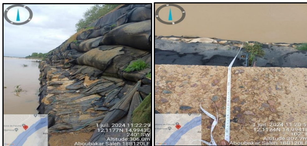
Photo 8 : Mesures de contrôle de l'érosion par le ministère de l'Environnement
