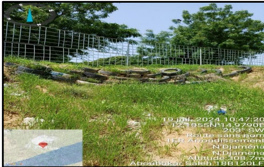
Photo 9 : Utilisation de pneus usagés pour lutter contre l'érosion des berges
