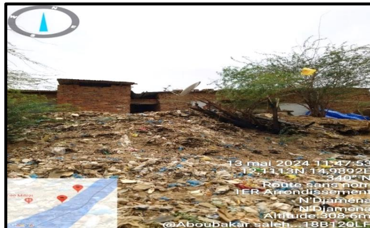
Photo 10 : Utilisation de déchets solides pour la stabilisation des berges
