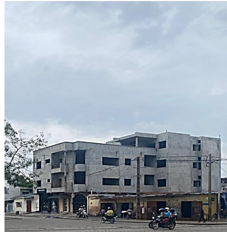
Photo 1b: Rénovation d'un bâtiment existant
