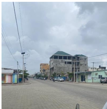
Photo 2a: Nouvelle voie pavé dans le 2 ème arr de Cotonou (quartier Lomnava)
