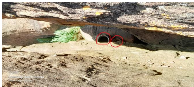
Photo N°12 : Localisation de 2 vases dégradés entre les rochers
