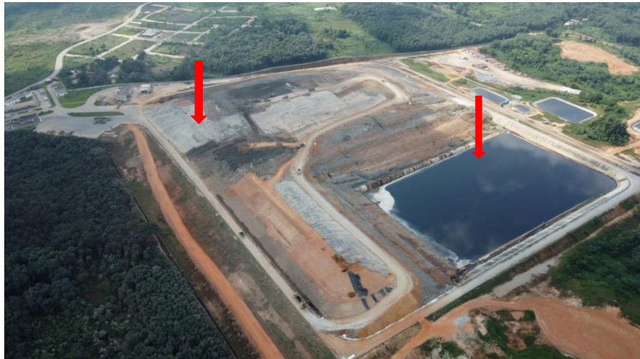
Photo 2 : Vue aérienne de casiers à moitié plein et des alvéoles de lixiviats
